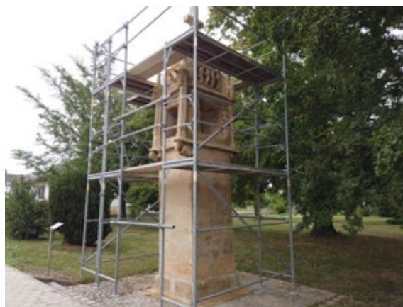
Foto: Die Restaurierung der Pestsäule kurz vor der Fertigstellung, nur mehr ein schöner warmer Tag wäre notwendig gewesen, um die abschließenden Arbeiten durchzuführen.
