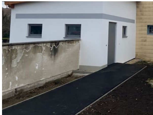
Zugangsweg zur WC Anlage am Friedhof
