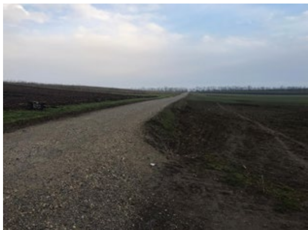
Der sanierte Güterweg (Feldgasse Dobermannsdorf in Richtung Hohenau)
